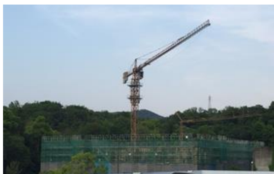
<第一期工事風景>
